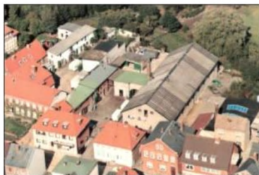
Luftaufnahme des Schlachtereibetriebes von Friedrich Horstmann, Neuwerkstraße Nr. 9, (1972)
