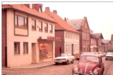
Neu errichtetes Wohn- und Geschäftshaus der Fleischer Horstmann in der Neuwerkstraße Nr. 9 im Jahre 1970
